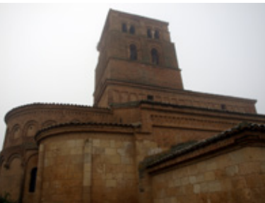
Abside de l'église du monastère
