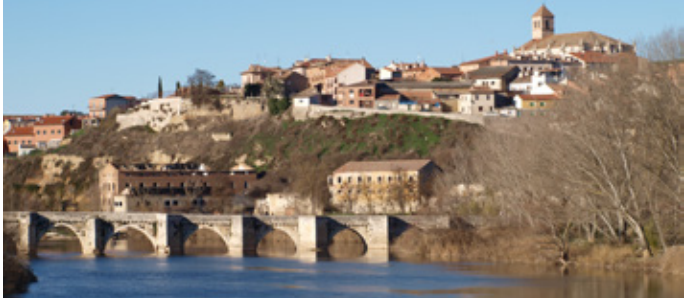
Vue d'ensemble de Simancas
