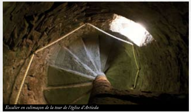
Escalier en colimaçon de la tour de l'église d'Artieda
