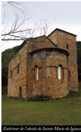
Exterieur de l'abside de Sainte Marie de Igüacel
