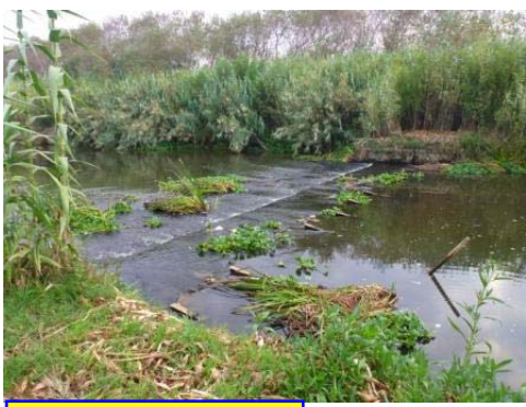
Canal de Riego
