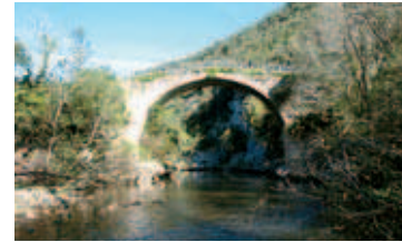
Pont du Tortorio sur la Nansa, à Camijanes
