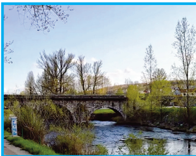
Puente sobre el Carrión
