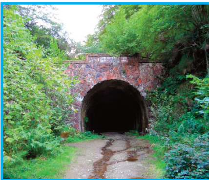
Túnel de La Engaña
