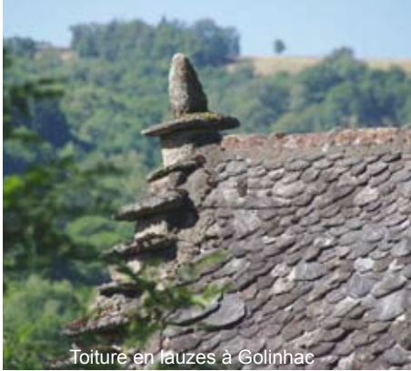
Toiture en lauzes à Golinhac
